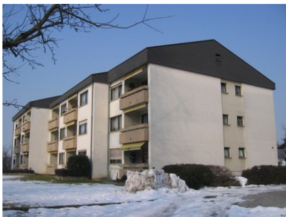
Obrázek: Obytný dům Rankweil-Schleipfweg před obnovou
